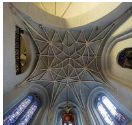
46. Šv. Mikalojaus bažnyčios presbiterijos tinklinis skliautas
