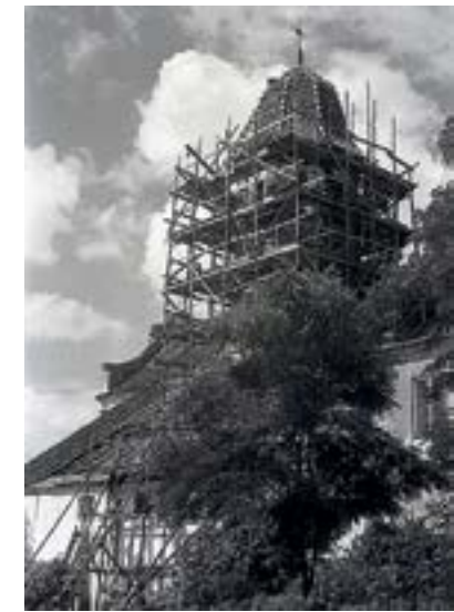
91. Remontuojamas bažnyčios bokštas. 1938
