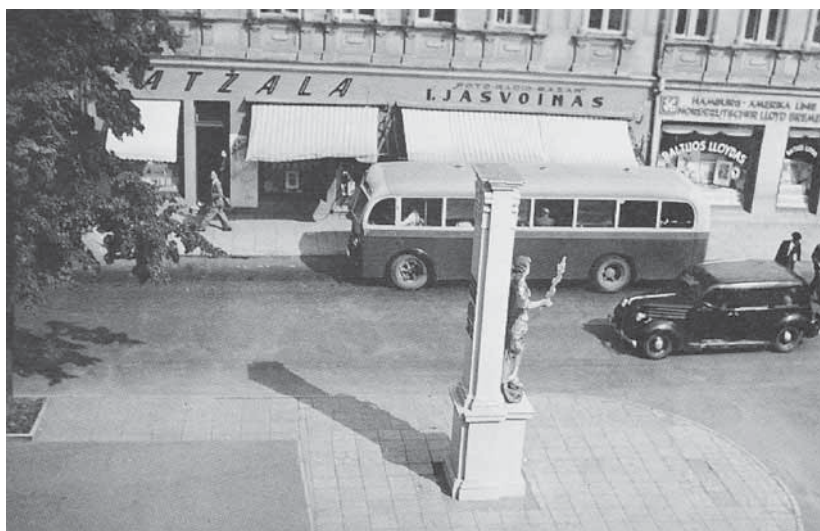
2 pav. Laisvės alėja 1939 m. Nuotraukoje matomas meksfalto grindinys ir kvadratinės šaligatvio plytelės
