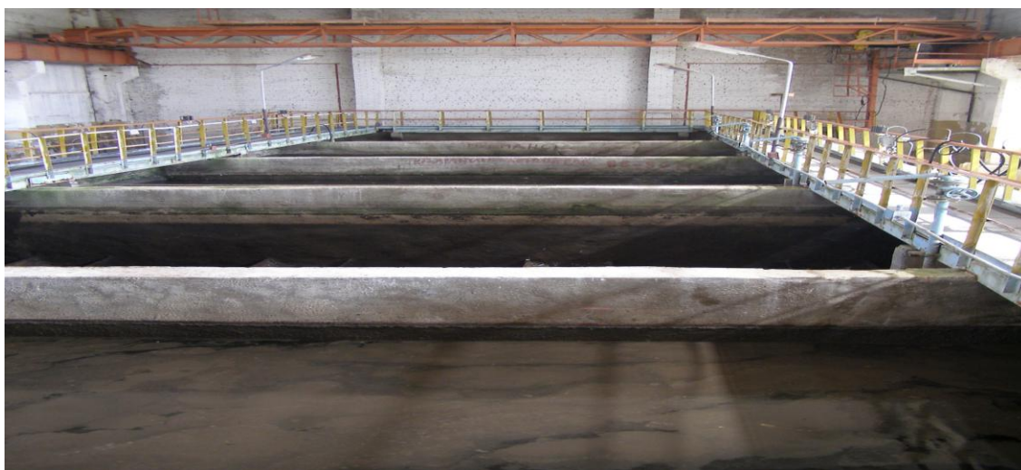
4.1 pav. Papildomo valymo smėliniai filtrai
